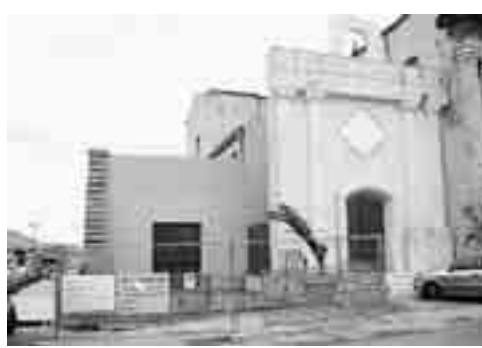
IL CANTIERE APERTO DAVANTI «U' RATÒ»
