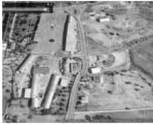
QUI L'AREA DOPO I LAVORI RITENUTI ABUSIVI
