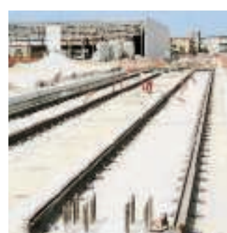
Il cantiere del tram
