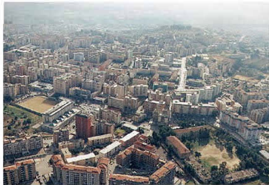
Veduta aerea del capoluogo nisseno
